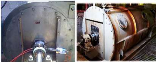
APLICACIÓN SELLADO DE GASES- SOPLADOR HORIZONTAL
